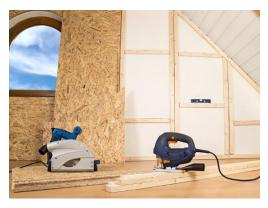
OSB-Platten werden als Bauplatten beim Rohbau und im Innenausbau als Wand- oder Dachbeplankung eingesetzt. Im Fußbodenbereich dienen sie als Verlegeplatte.
